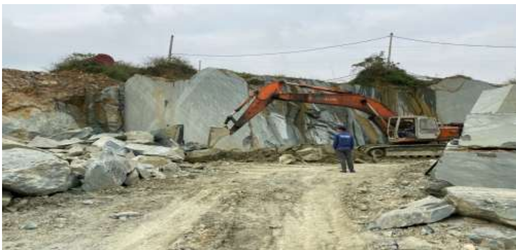
Hình 1.2. Áp dụng HTKT bằng dây cưa cắt tại mỏ đá Split Hà Tân - Công ty Châu Quý - Hà Trung – Thanh Hóa
